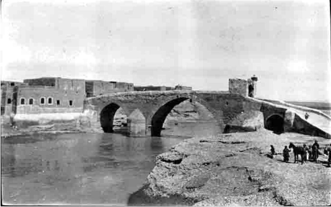
Altunköprü şehrinin Aşağı Zap Suyu üzerindeki eski osmanlı köprüsü (Orug - 2015)
