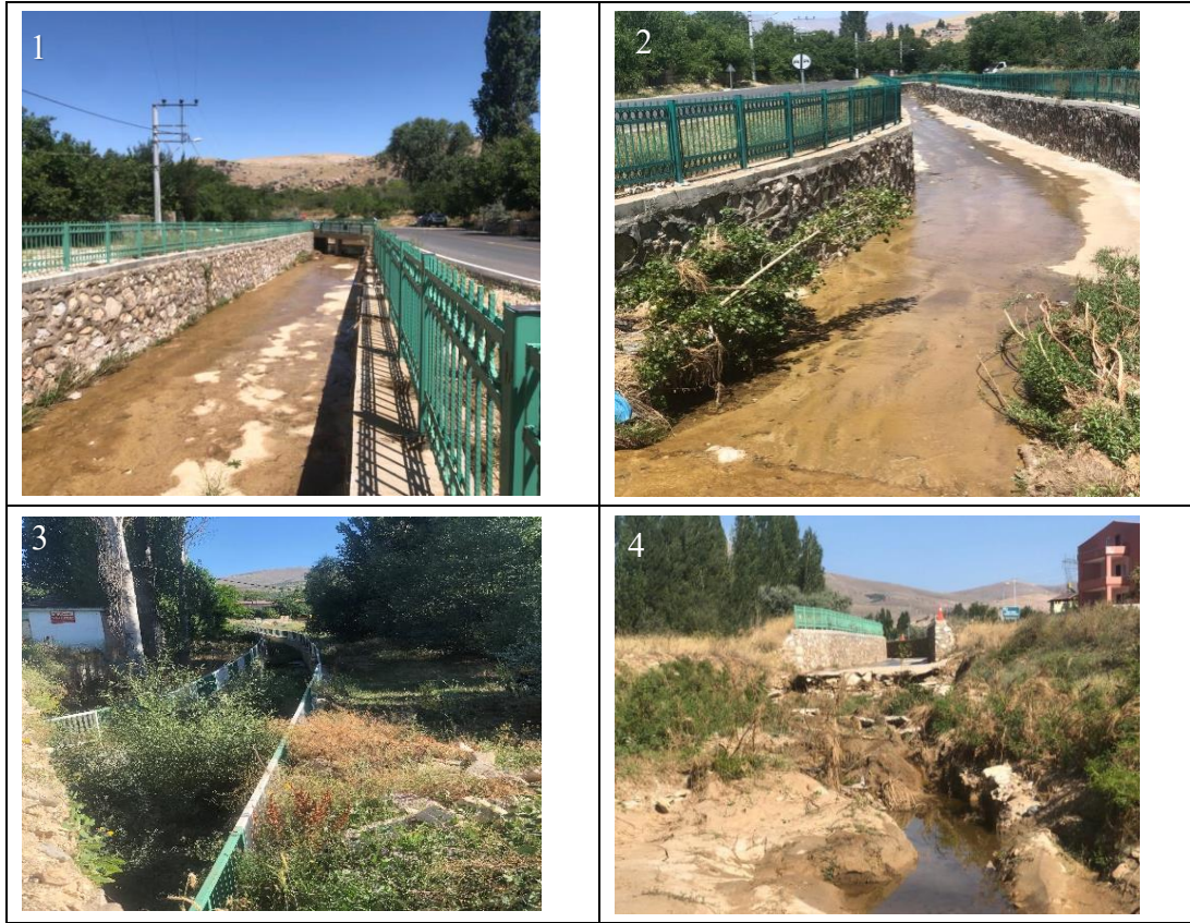
Resim 1: 25 Temmuz 2022 yılında çekilmiş çalışma alanı üzerinde kurulan suni kanallar (1-2-3) ve yıkılmasıyla çevreye verdiği zararın görünümü (4).
